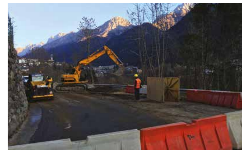
da sinistra: lavori in località Lantana (Castione) e a Schilpario
