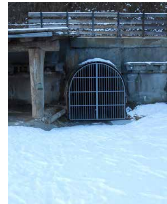
Sopra: piazzale ed ingresso alla galleria. Nella pagina accanto: interno della galleria.
