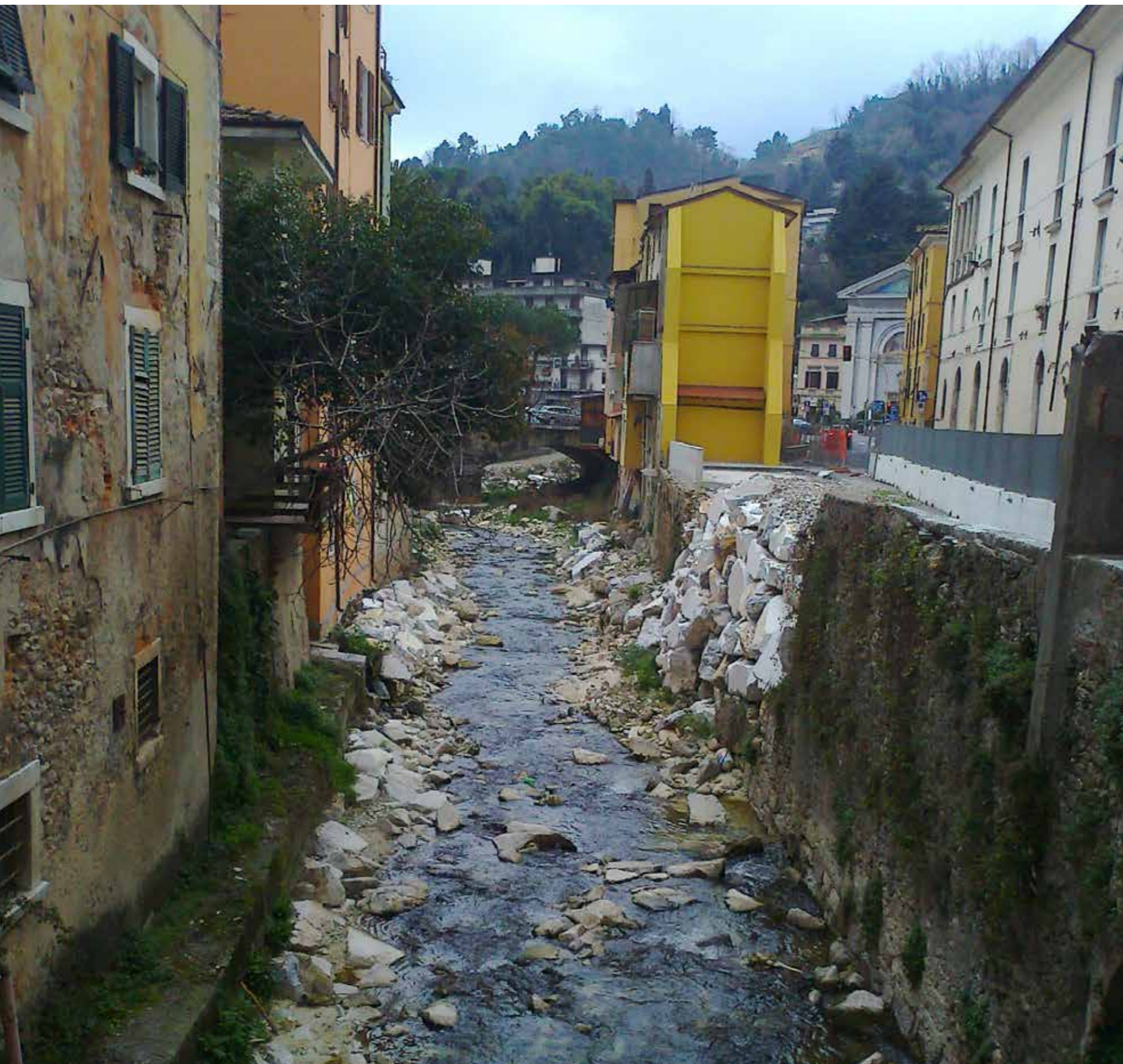
Carrara 2012: alveo torrente Carrione
